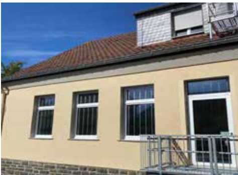
Neue Fenster des Gemeindehauses in Evingsen
